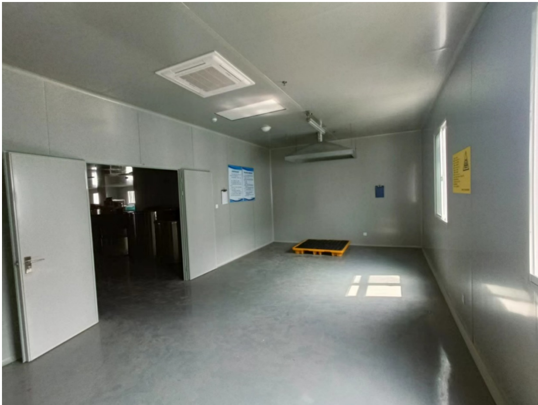
危险废物仓库
